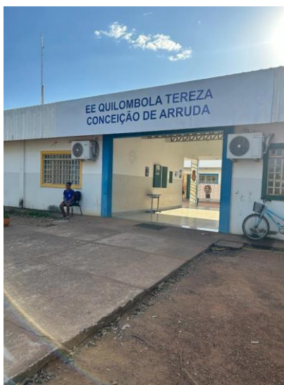
Figura 1 - Fachada da Escola Tereza Conceição de Arruda
