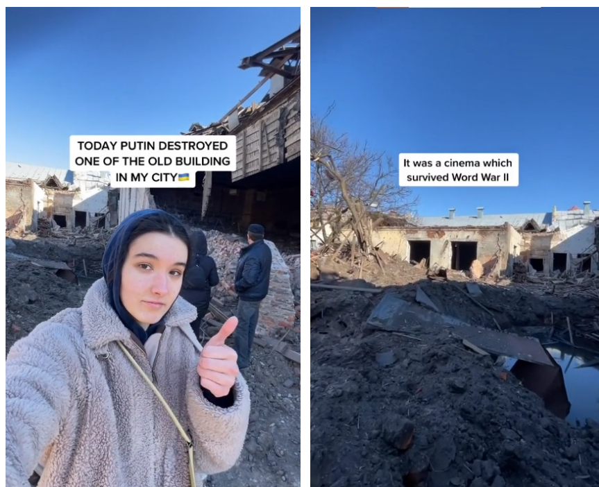
Figura 5 - Imagens da destruição do edifício mais antigo da cidade de Shashenok após bombardeio russo. 22
